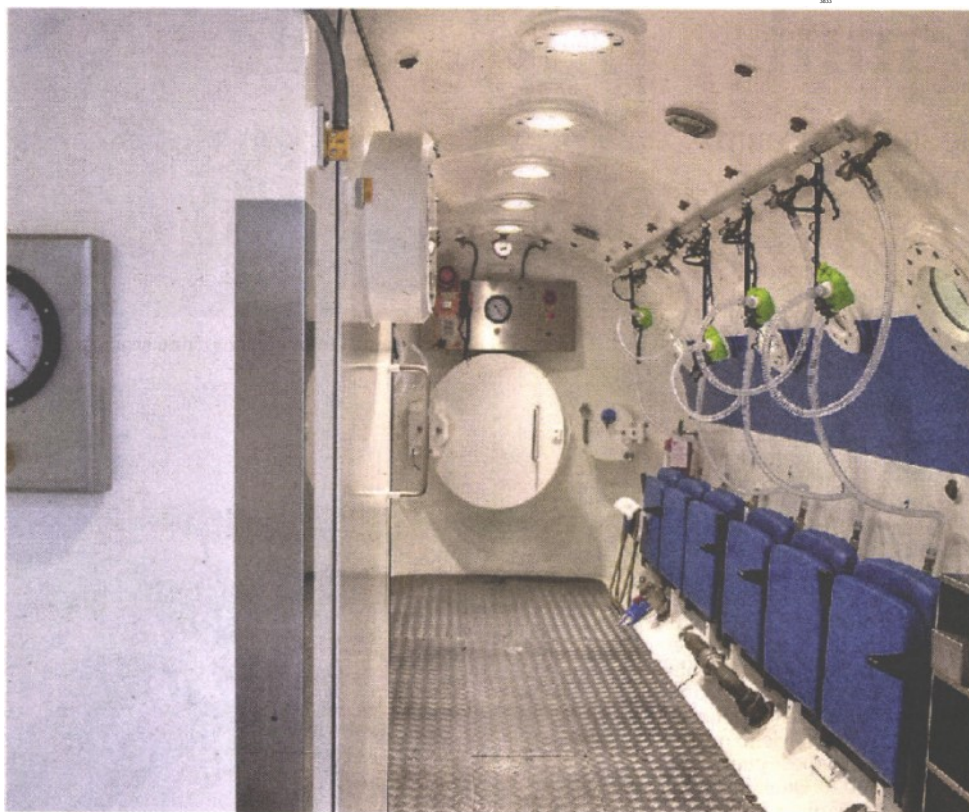
CENTRO PADOVANO La camera iperbarica dove vengono trattati i casi di intossicazione da monossido
