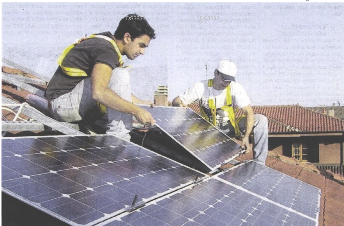
TRANSIZIONE VERDE Due artigiani stanno installando i pannelli fotovoltaici sul tetto di un'abitazione a Padova
