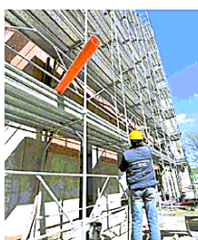
Operaio a lavoro in un cantiere
