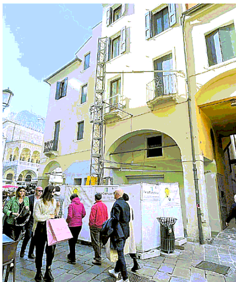
Una delle impalcature dei lavori di ristrutturazione in centro
