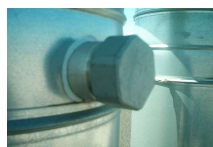
di diametro 3" (76 mm) con filetto esterno (camini \varnothing < 0,4 m)
